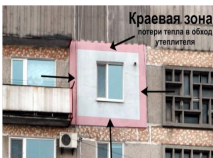
Рисунок 2. Утепление фасада панельного дома фрагментами
